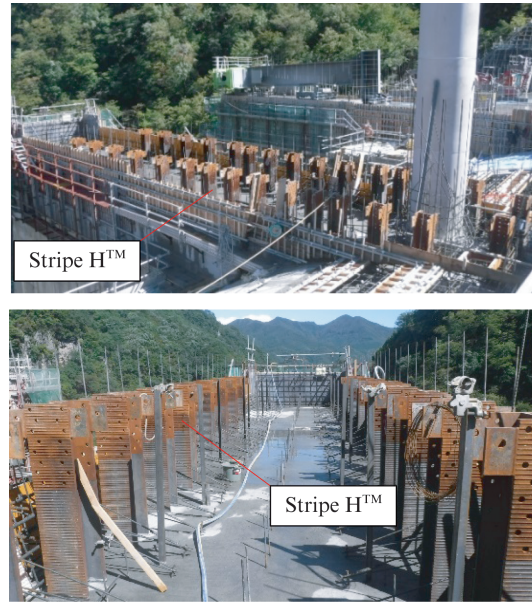
写真 5 施工状況 Photo 5 Construction scene
