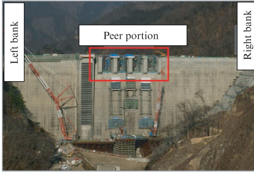
写真 4 ダム堤体越流部橋脚の設置位置 Photo 4 Installation position of sluice gate
